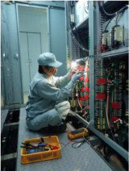
ケーブル接続作業の様子
